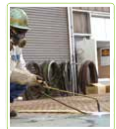
撓鉄(ぎょうてつ)作業の様子
