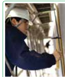
船体検査の様子
