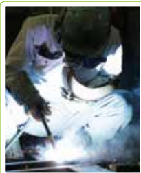
部品の溶接作業の様子
